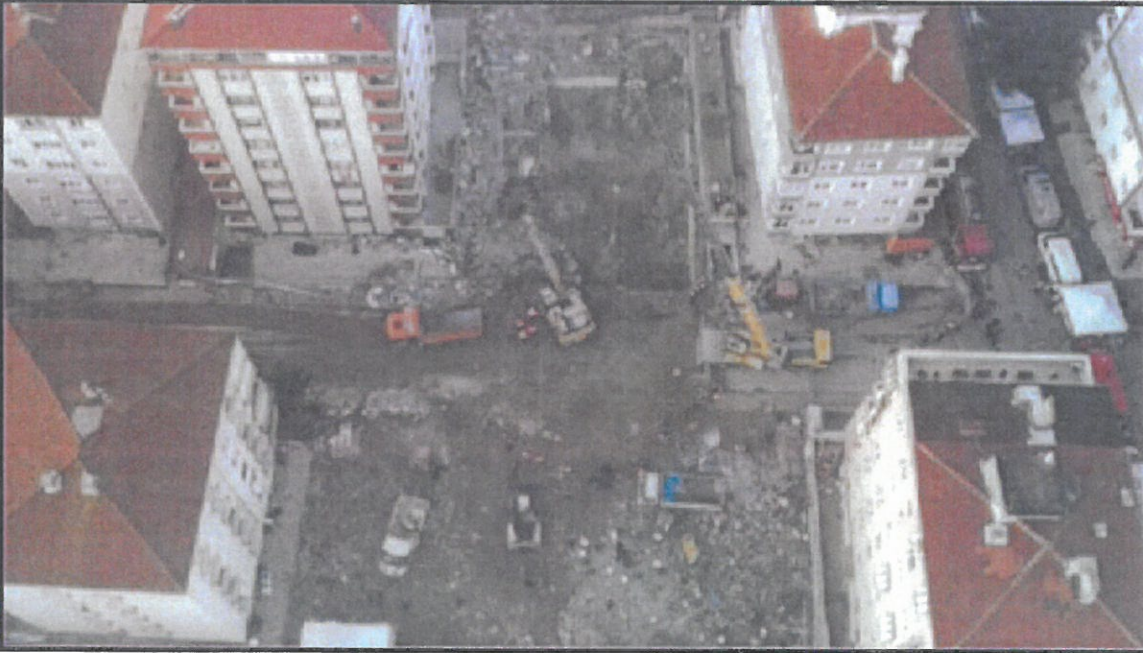
Şekil 5. 6 Şubat 2019 İstanbul'un Kartal ilçesinde çöken bina ve sonrası oluşan enkaz
