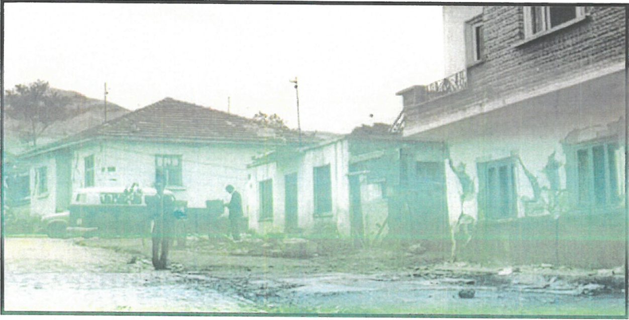
Şekil 4. 12 Mayıs 1971 Burdur depreminden sonra Burdur' da bir sokak. Burdur ve çevresinde gece meydana gelen 6,2 şiddetli depremde 57 kişi öldü, 1.162 ev yıkıldı.
